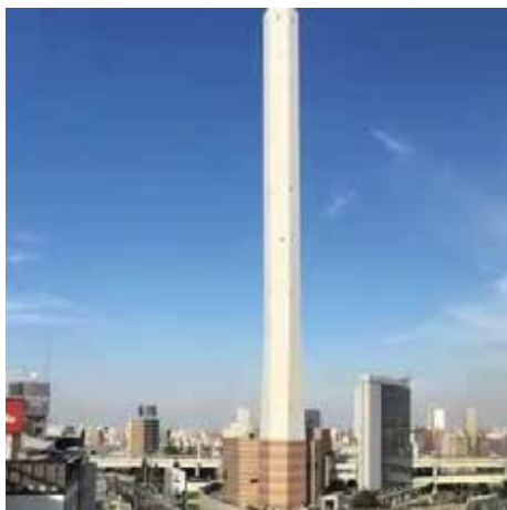
丰岛区垃圾焚烧厂
