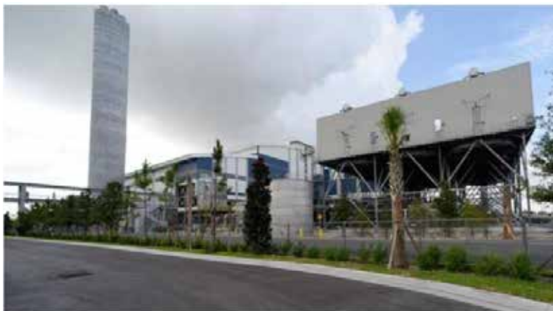
佛罗里达棕榈海滩垃圾焚烧发电厂
