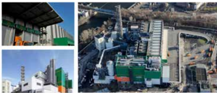
德国 Ruhleben 垃圾焚烧发电厂
