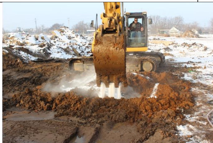
污染土壤原位化学氧化—药剂搅拌处理
