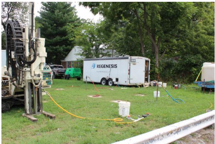
地下水修复原位注入修复药剂
