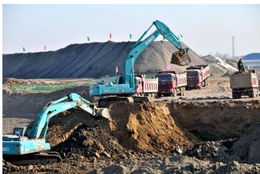
污染土壤开挖
