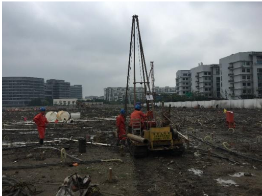
地下水抽提井安装
